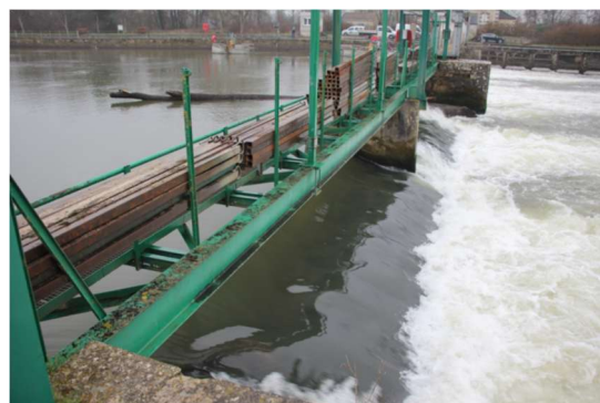
Photo 56 et Photo 57 : Péchoir – passerelle n°3 sur déversoir à aiguilles
