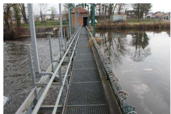
Photo 32 et Photo 33 : Les Boisseaux – passerelle sur déversoir à aiguilles
