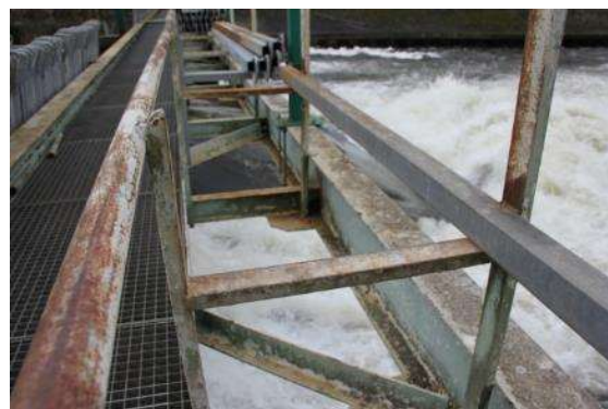
Photo 44 et Photo 45 : Bassou – passerelle sur déversoir à aiguilles
