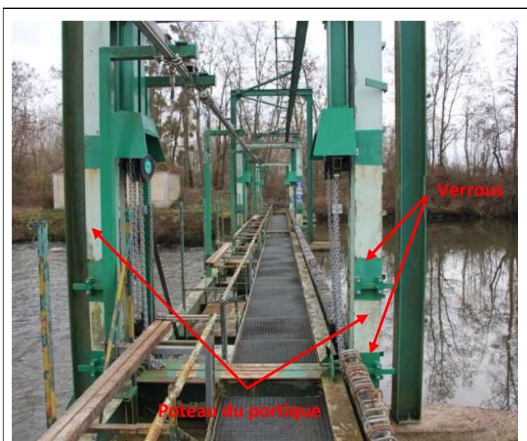
Photo 1 : passerelle levante - barrage de la Gravière
