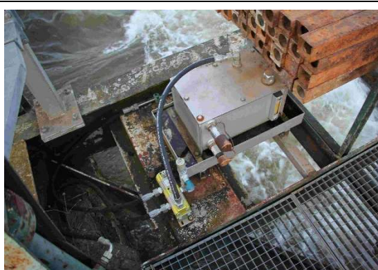
Photo 16 : La Chaînette – centrale hydraulique et vérin RG
