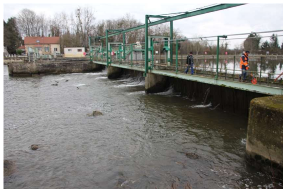
Photo 49 : La Gravière – vue de l'aval RD sur déversoirs à aiguilles
