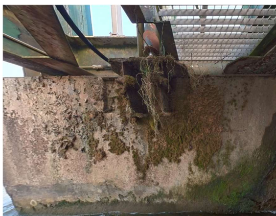
Photo 14 et Photo 15 : La Chaînette – dispositif d'appui des vérins
