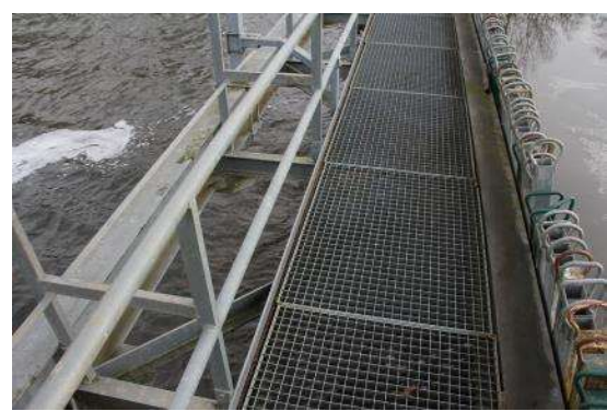
Photo 32 et Photo 33 : Les Boisseaux – passerelle sur déversoir à aiguilles
