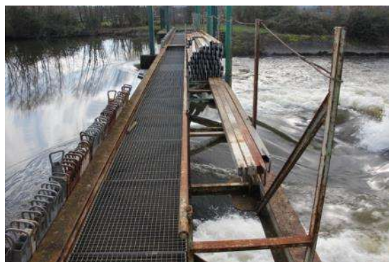
Photo 38 et Photo 39 : Monéteau – passerelle sur déversoir à aiguilles
