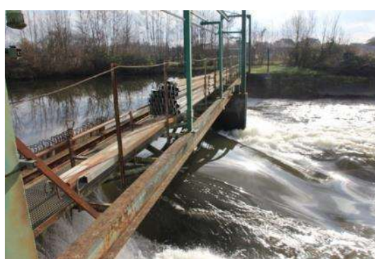
Photo 38 et Photo 39 : Monéteau – passerelle sur déversoir à aiguilles
