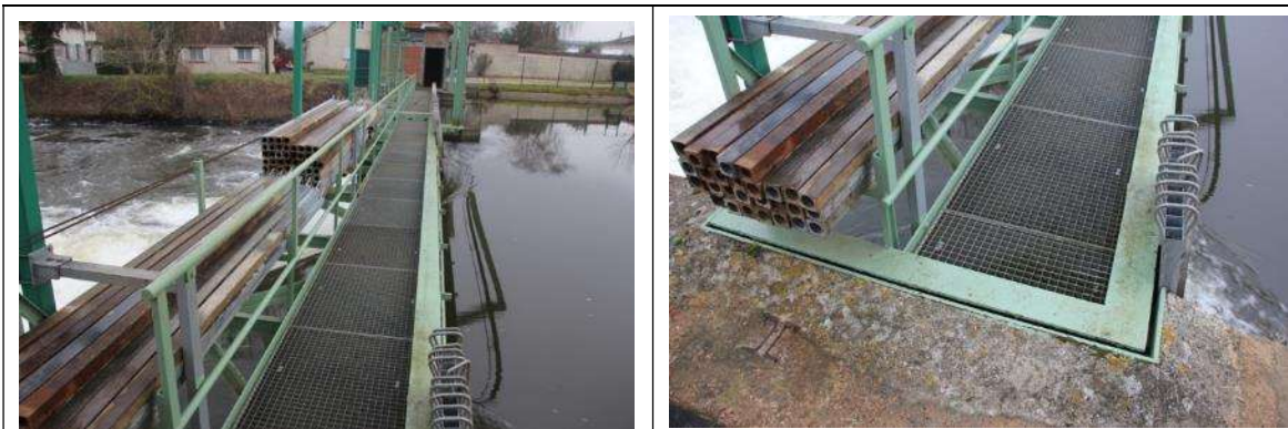
Photo 26 et Photo 27 : Les Dûmonts – passerelle sur déversoir à aiguilles
