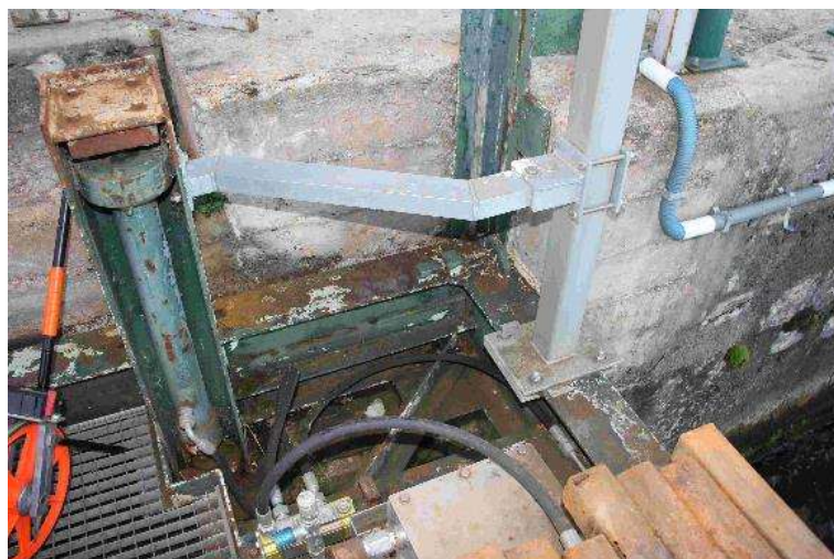
Photo 12 et Photo 13 : La Chaînette – vérin hydraulique P1
