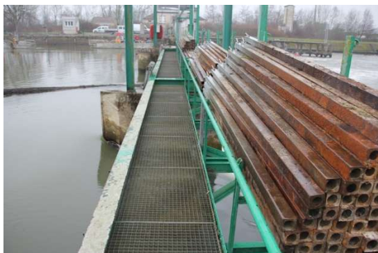
Photo 56 et Photo 57 : Péchoir – passerelle n°3 sur déversoir à aiguilles
