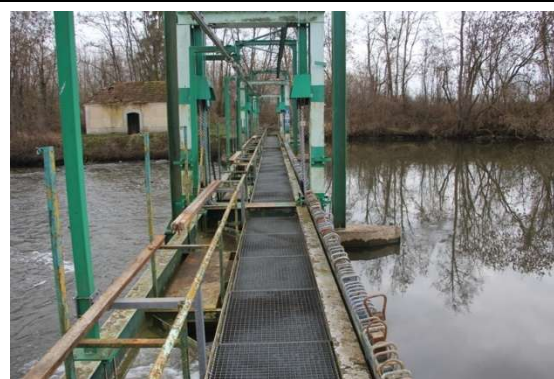
Photo 51 : La Gravière – palans et verrous de blocage
